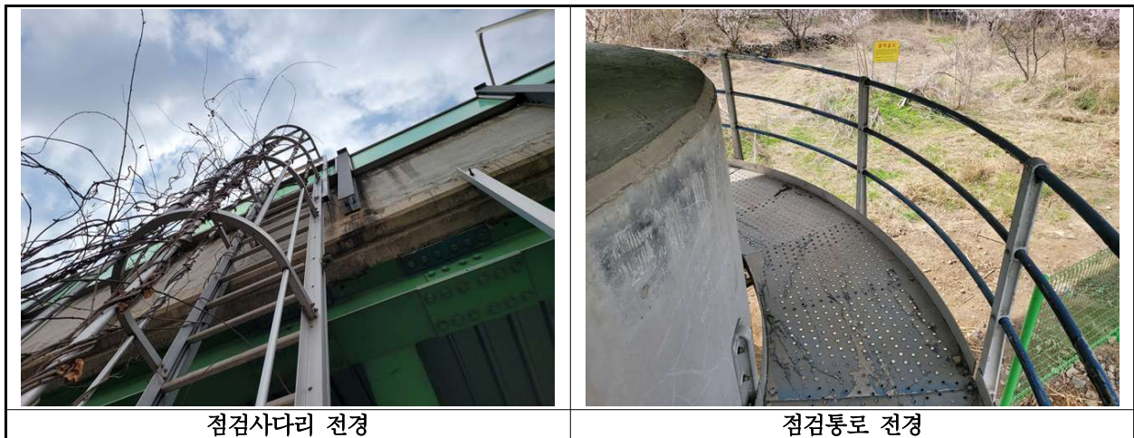
【사진 5.3.25】 교량 점검시설 전경
