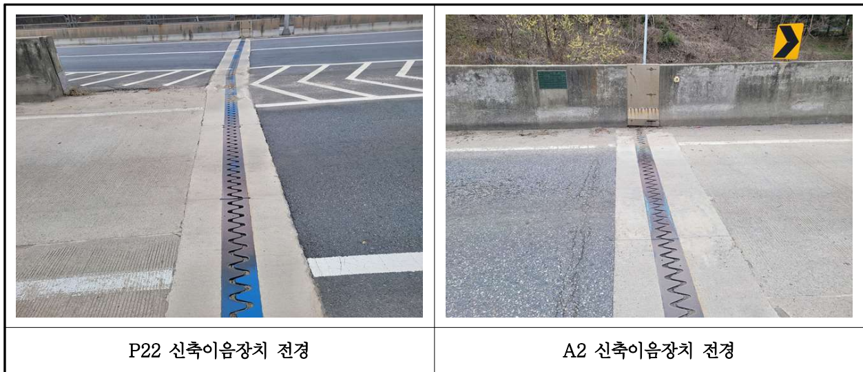
【사진 5.3.16】 신축이음장치 전경
