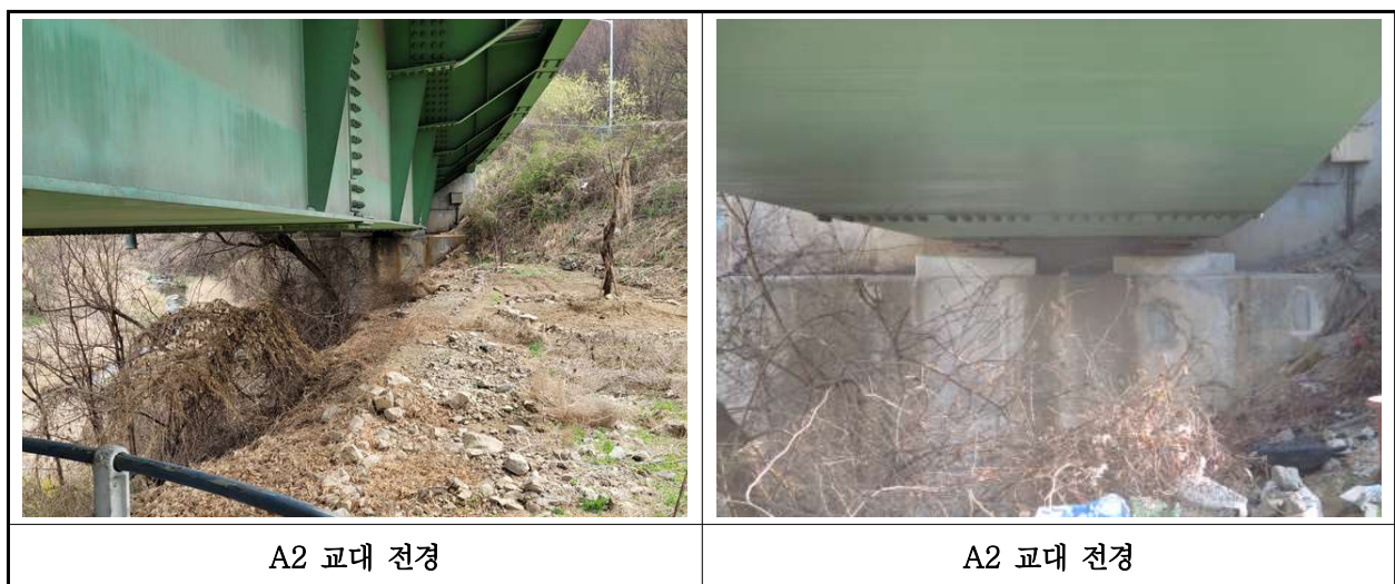
【사진 5.3.10】 교대 전경
