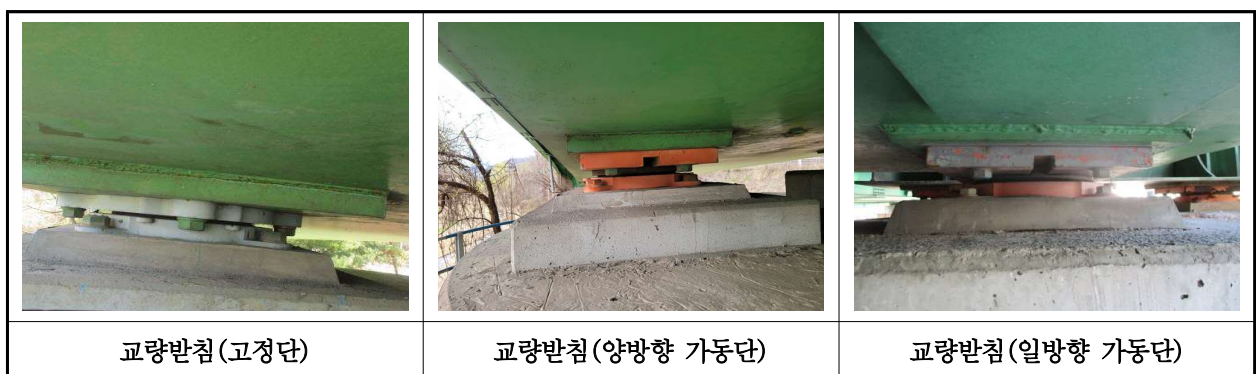
【사진 5.3.14】 교량받침 전경
