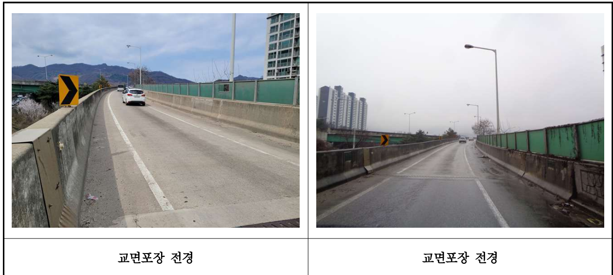
【사진 5.3.19】 교면포장 전경
