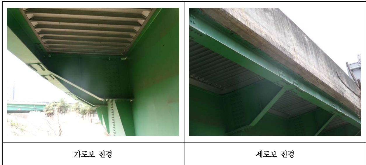
【사진 5.3.8】 가로보 및 세로보 전경
