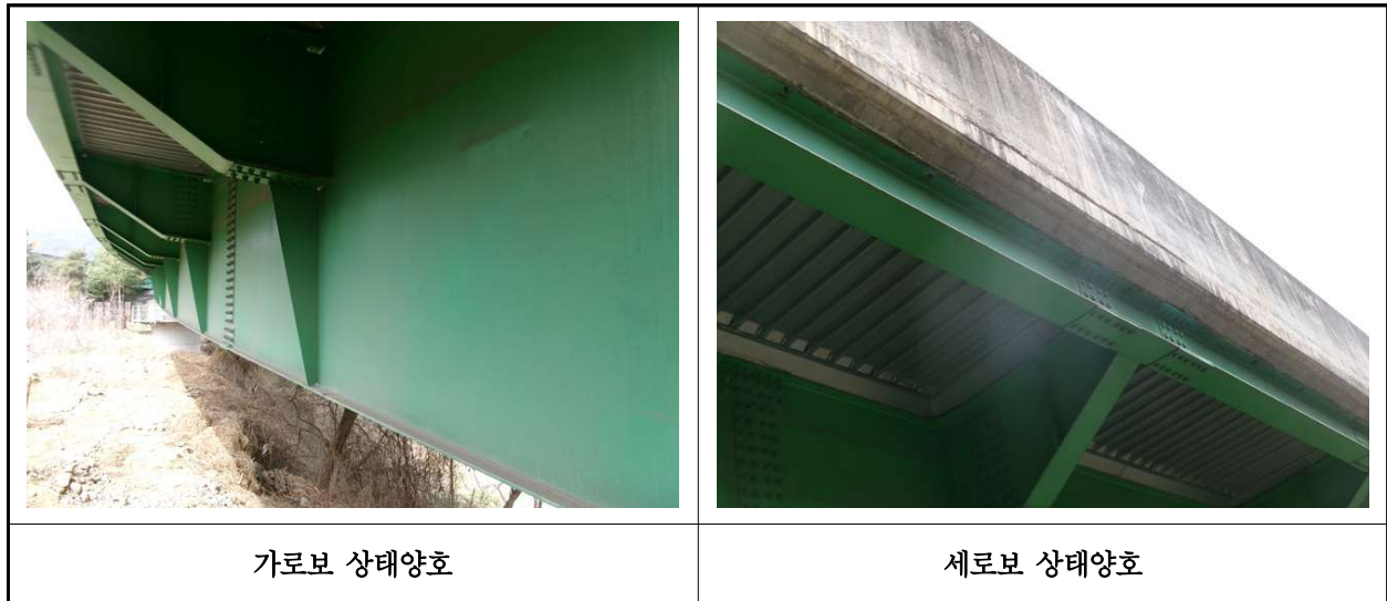
【사진 5.3.9】 가로보 및 세로보 손상현황
