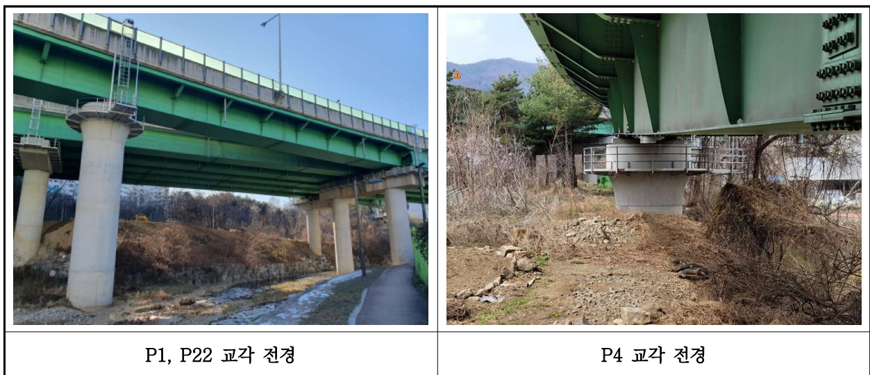
【사진 5.3.12】 교각 전경
